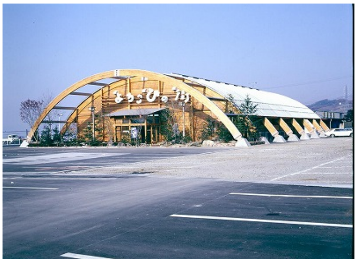
小諸店 (竣工:昭和63年)
