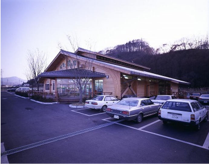
臼田店 (竣工:平成4年)
