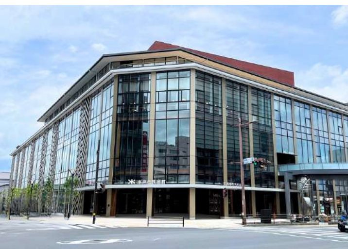
令和4年 2022年：水戸市民会館（茨城県水戸市） 地上4階/地下2階 カラマツ構造用集成材 1400m 3 燃エンウッド® 使用
